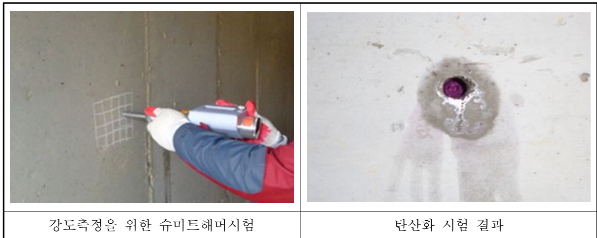
【사진 Ⅱ.2-4】 시험 및 측정 전경
